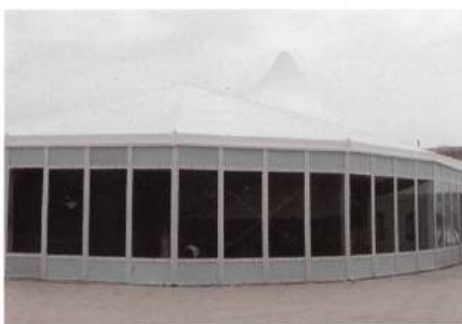
玻璃墙 Glass wall
